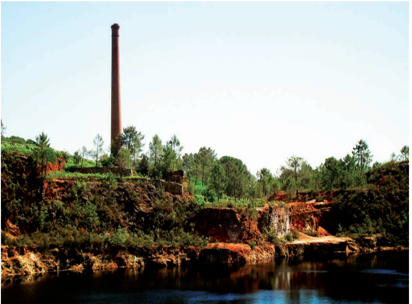
Chimenea en Aguas Teñidas (Huelva).
