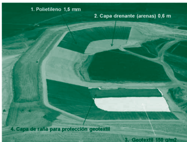
Preparación de la instalación de estériles de la Mina
