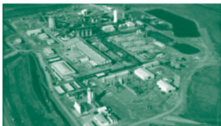
Planta Hidrometalúrgica de las Cruces
