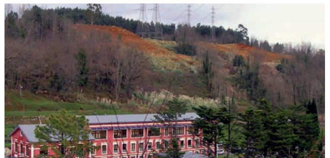
Vista del estado actual del dique de La Luciana.
