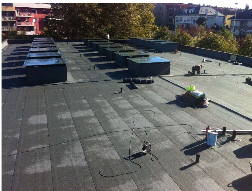
Obra en la cubierta de la Facultad de Medicina.
